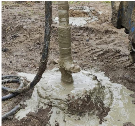
Рисунок 2.5 – Общий вид рабочего органа (смесителя) при изготовлении ГЦЭ
