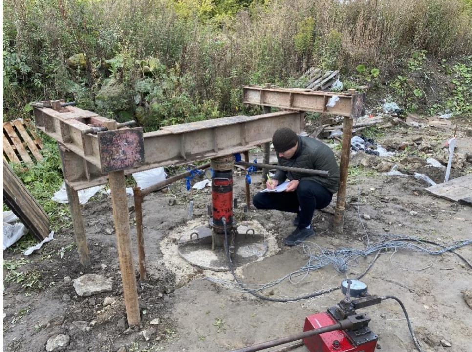
Рисунок 2.9 – Общий вид установки для испытания плоским штампом на опытной площадке
