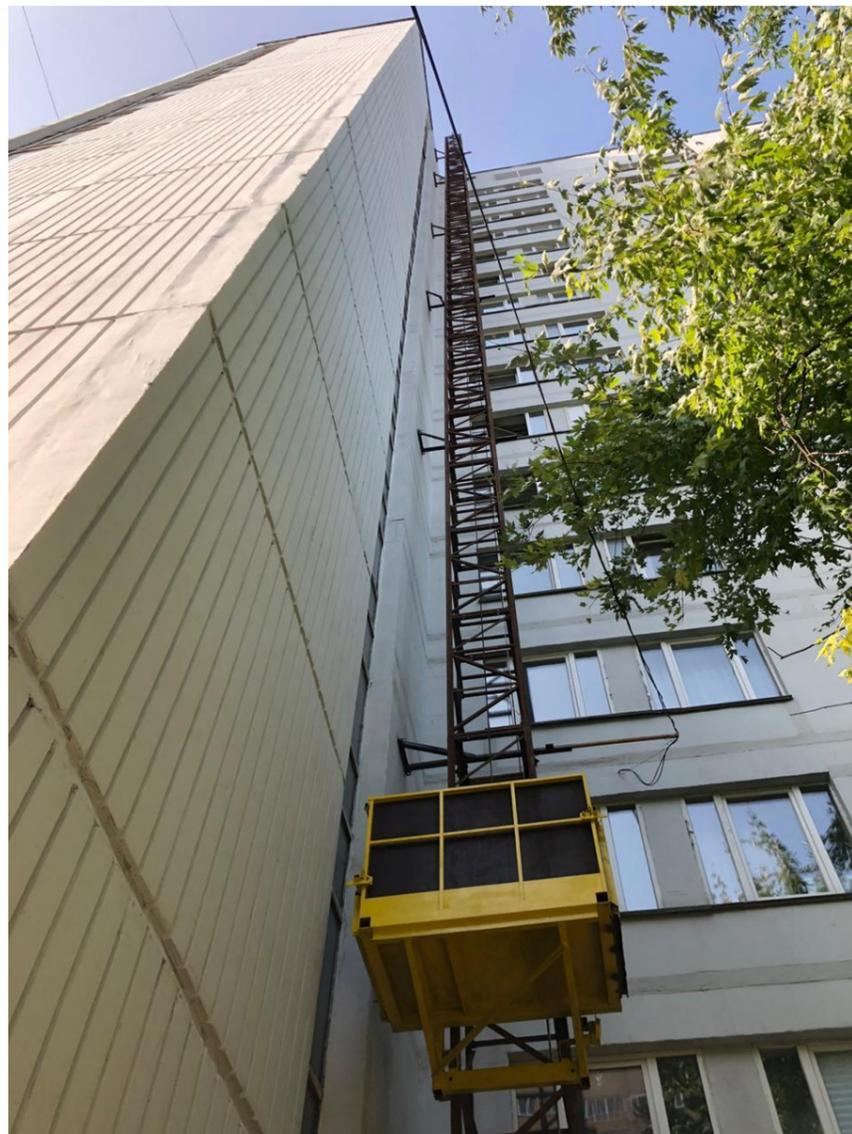
❖ Выполнен монтаж грузового подъемника для подъема строительных материалов и спуска строительного мусора
