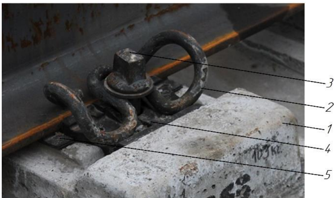
1-опорный блок; 2-упругая клемма Skl 30; 3- путевой шуруп Ss 35 с несъемной шайбой; 4- боковой упор Wfr 30K; 5-подрельсовая прокладка Zw 148 Рисунок 3.6 – Рельсовое скрепление W 30 НН
