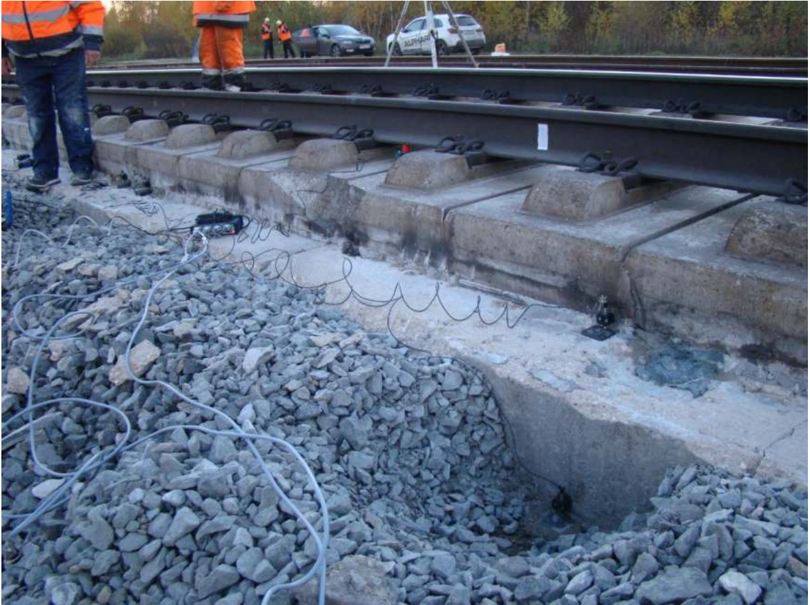
Рисунок 3.20 – Установка датчиков перемещения
