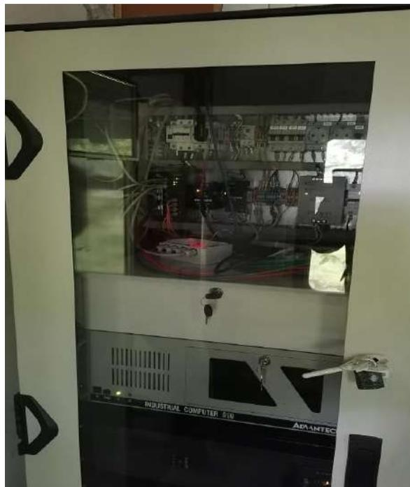
**Рисунок 2.17 – Центральная стойка контроля и управления**
