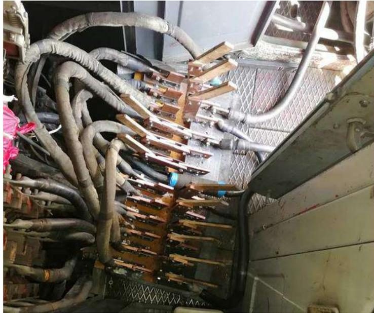
**Рисунок 2.6 - Блок разъединителей**
