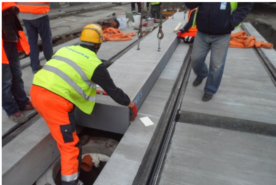
Рис. 9. Укладка плиты междупутья в районе канализационного люка.
