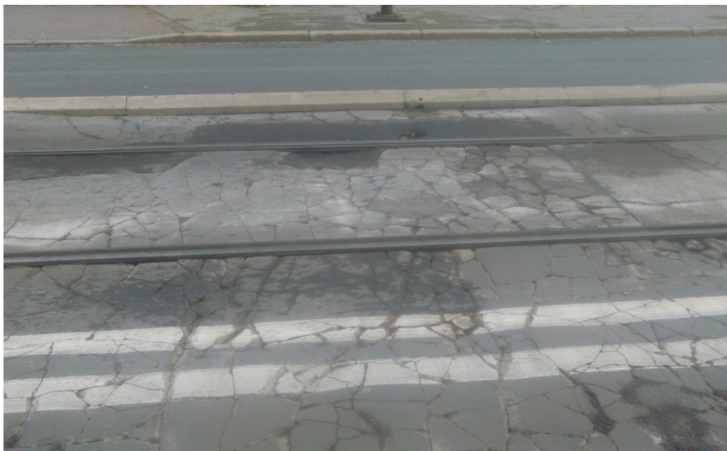
Рис. 1. Существенные трещины и сколы в покрытии.
