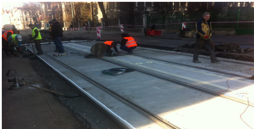
Рис. 10. Установка опалубки из пенополистирола перед выливанием бетонной смеси.
