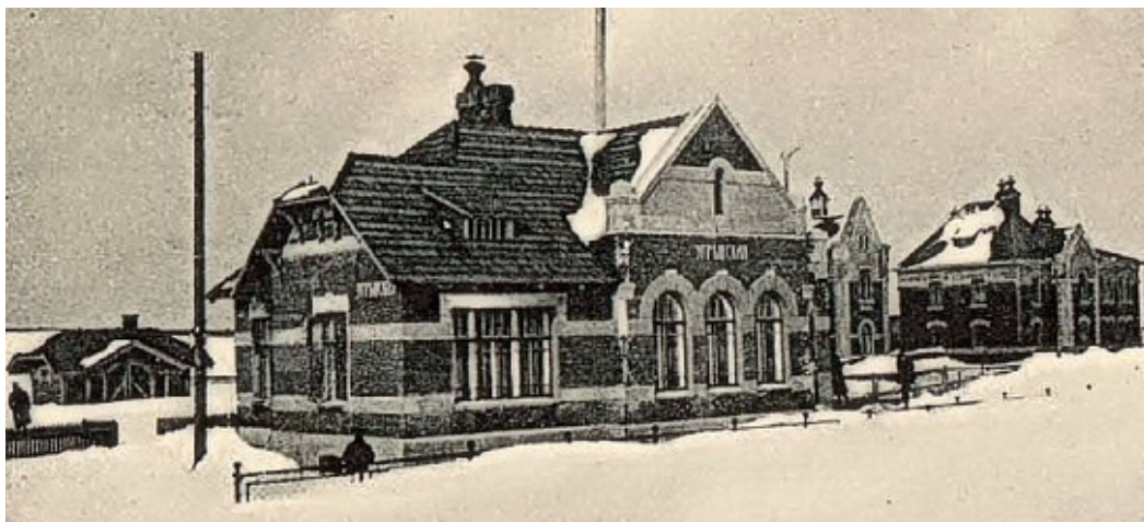
Пассажирское здание на станции Угрешская 1907.
