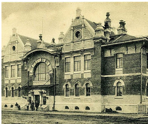
К. Фишер. Станция Воробьевы горы 1907 г.
