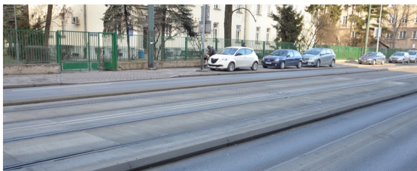
Рис. 11. Рельсовое покрытие после ремонта с системой плит заводского изготовления TINES LC–L XL.
