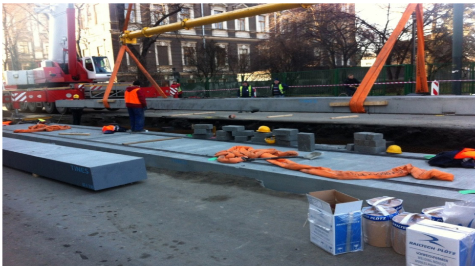
Рис. 7. Укладка плиты TINES LC–L XL.
