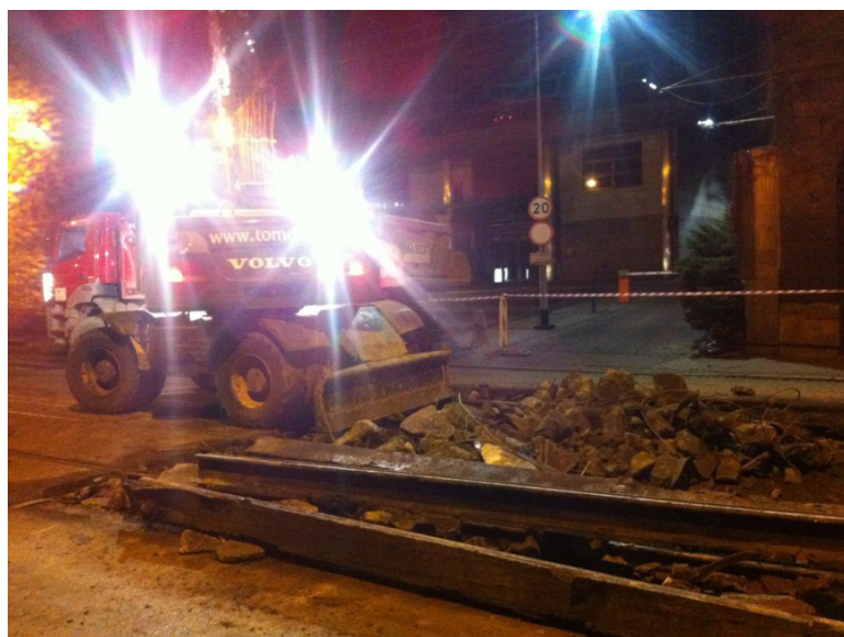
Рис. 6. Демонтаж существующего полотна.
