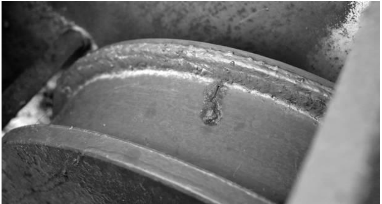
Рисунок 4.8 – Колесо крана с изношенной ребордой, восстановленной сваркой и не отремонтированной дорожкой качения
