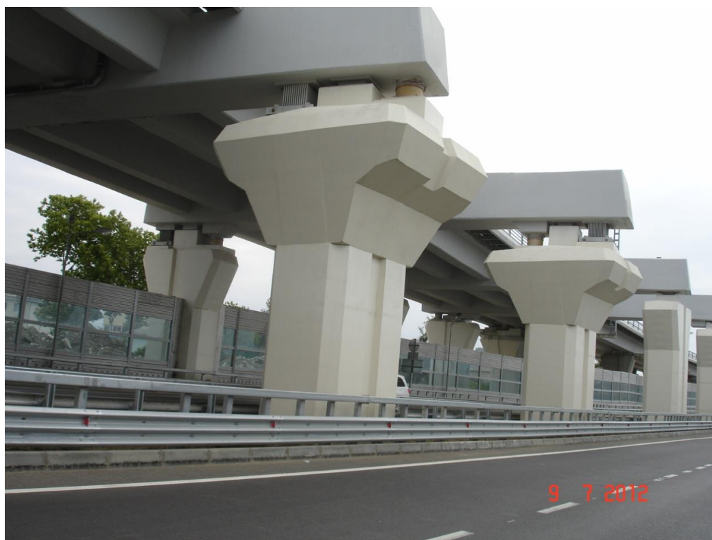
Рисунок 4.17 - Внешний вид моста с параллельно установленными гибкой опорной частью и демпферами
