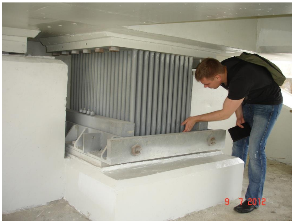
Рисунок 4.18 - Вид установленной гибкой опорной части в виде стержневого амортизатора
