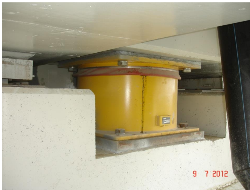
Рисунок 4.20 - Внешний вид вязкого демпфера фирмы «Вибросейсм»
