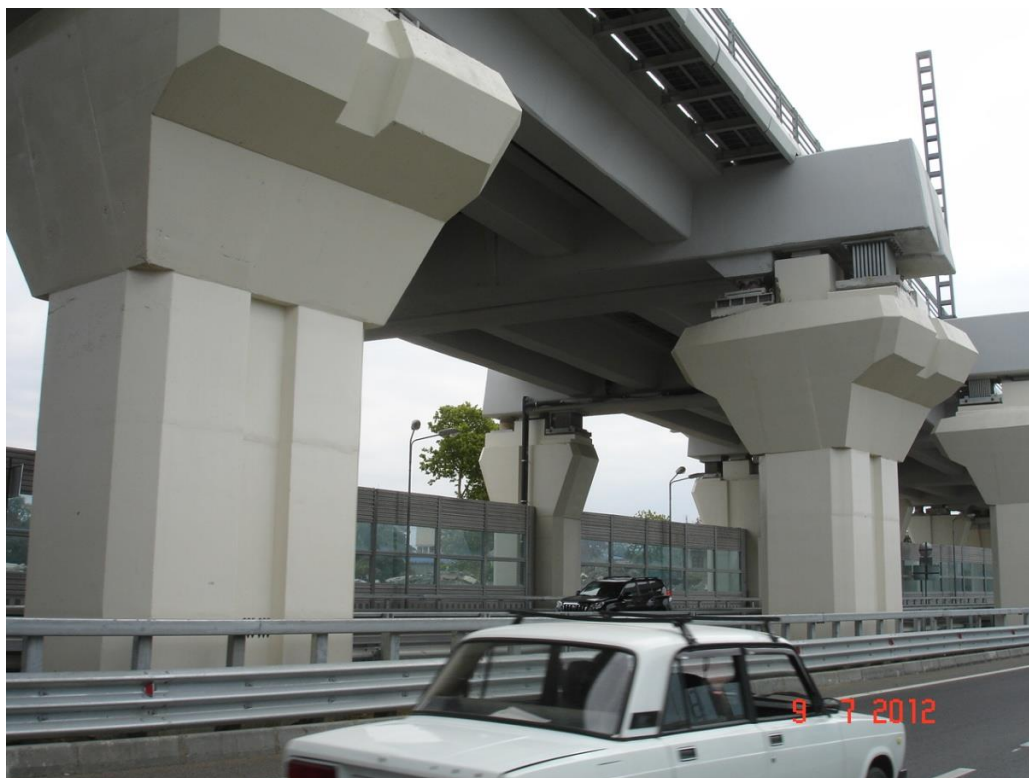
Рис.4.16 Внешний вид моста с параллельно установленными подвижной и гибкой опорными частями
