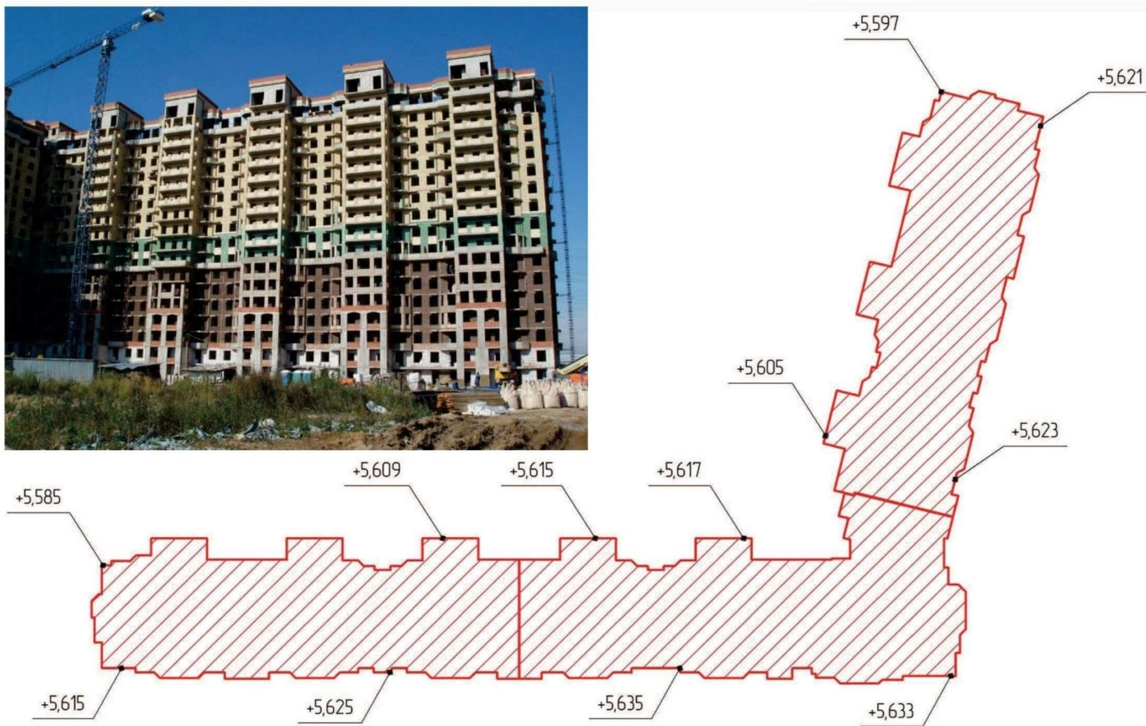
Рис.7.25. Наблюдаемые величины осадок корпуса №16 на момент окончания строительства, см
