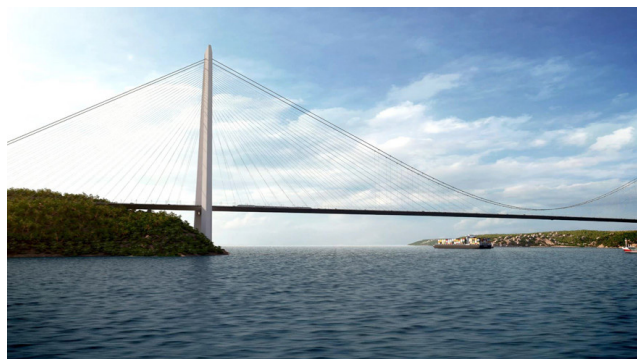
Рис. 3. Гибридный кабельно-вантовый мост через пролив Босфор.
