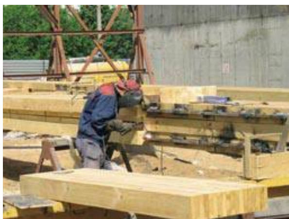
Рисунок 1.17 – Монтаж деревянных конструкций на клеенных стержнях
