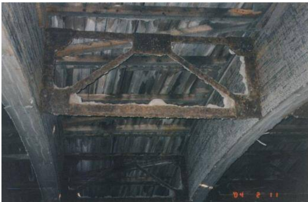
Рисунок 2.5 – Связевая ферма на складе руды
