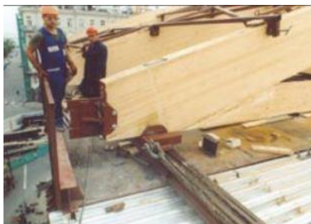
Рисунок 1.17 – Монтаж деревянных конструкций на клеенных стержнях
