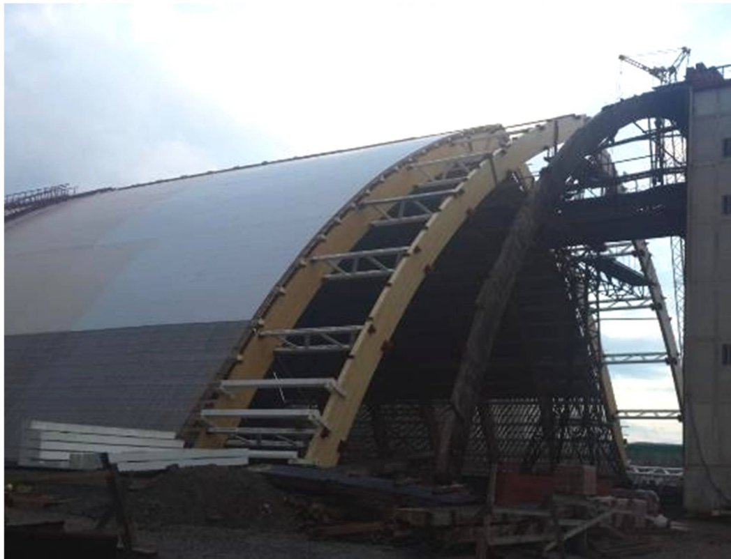
Рисунок 2.1 – Стрельчатый склад пролетом 45 метров
