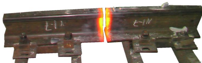
Рисунок 60 – Подогретье концы рельсов
