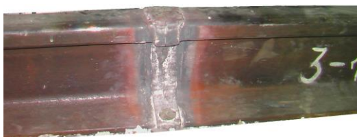
Рисунок 54 – Сварное соединение рельсов
