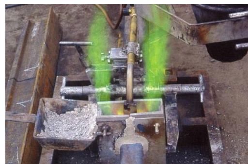
Рисунок Д-6 – Предварительный подогрев торцов рельсов в стыке
