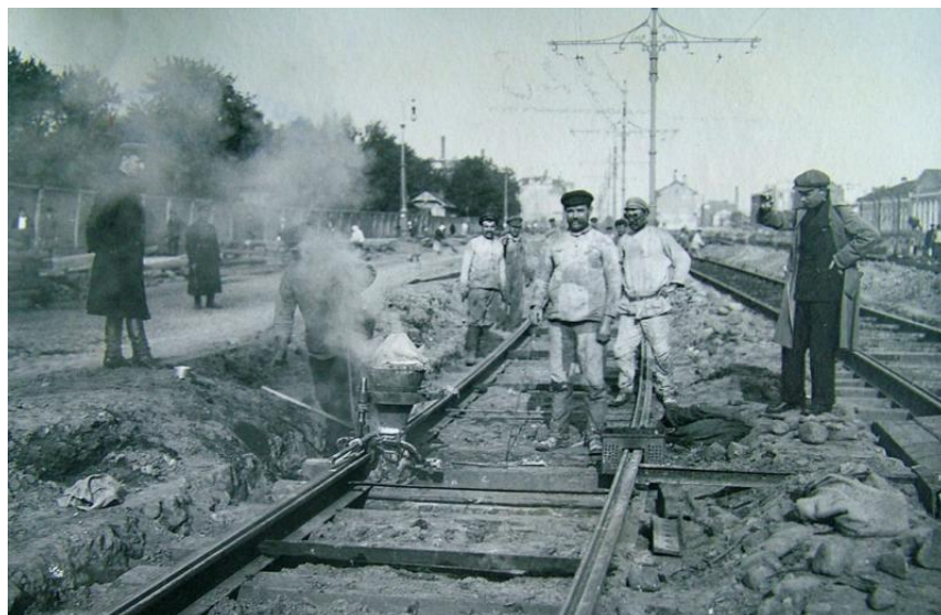
Рисунок 47 – Капитальный ремонт в 1923 г.
