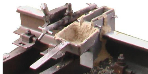
Рисунок Д–3 – Шлакоборник, установленный на одной из полуформ
