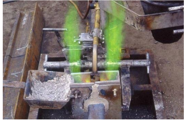
Рисунок 59 – Предварительный подогрев торцов рельсов в стыке
