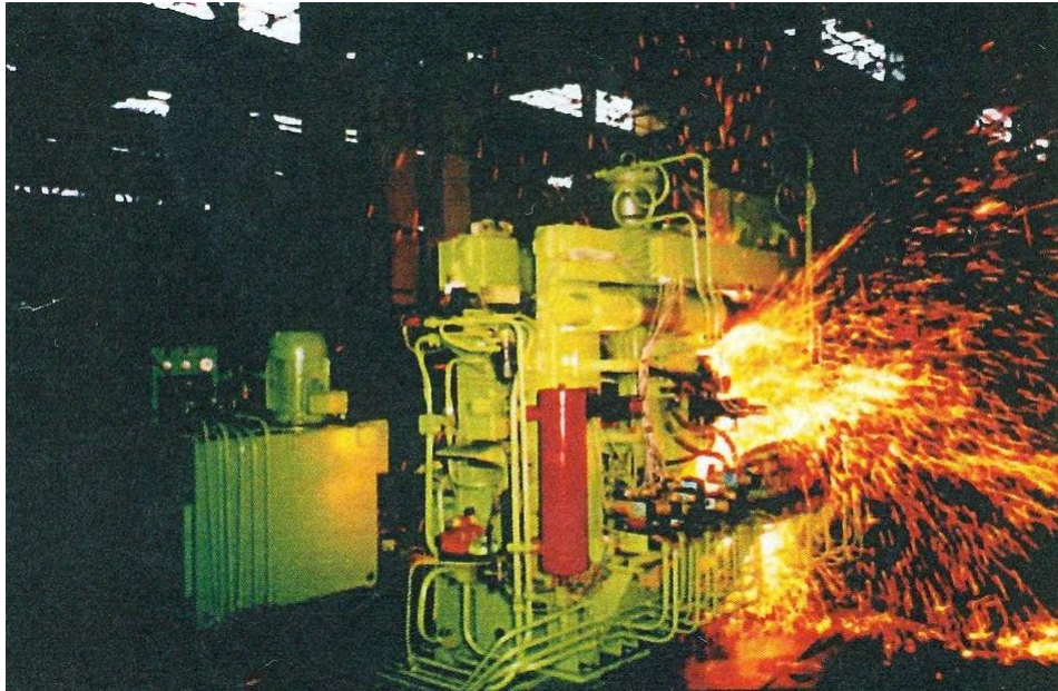
Рисунок 51 – Электроконтактная сварка рельсов 1
