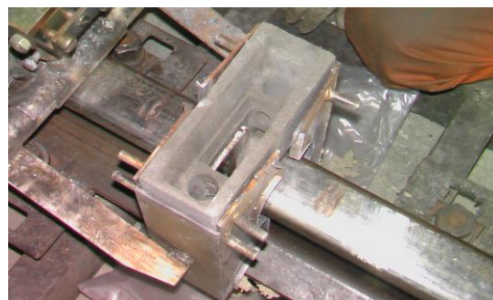
Рисунок Д-2 – Форма в сборе на стыке рельсов с фиксацией полуформ комбинированной стойкой
